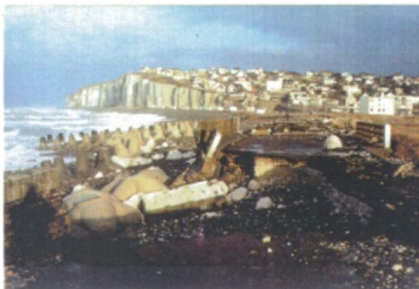
Figure 2 : destruction de la route CD222 lors de la tempête de novembre 1977
