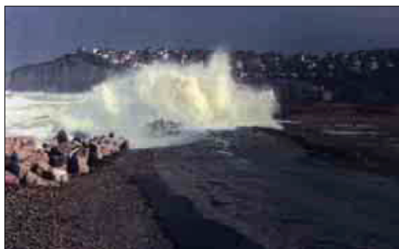
Figure 3 : franchissement de vague par dessus la digue de Criel-sur-Mer, 27-28 février 1990 (Cliché S. Costa)
